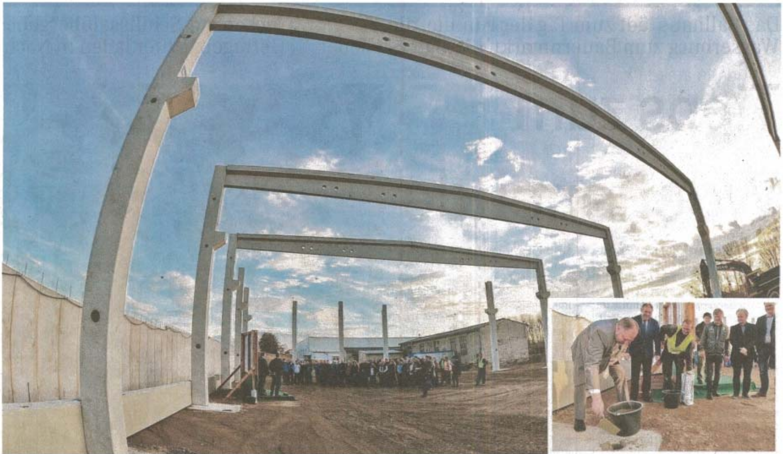
Die Stützen bilden das Skelett eines Teils der Halle, die bei Rulmeca entsteht. Die Tragrolle, die OB Andreas Michelmann im Boden versenkte, enthält eine tagesaktuelle Zeitung, Betriebsunterlagen, Bilder und Münzen.
